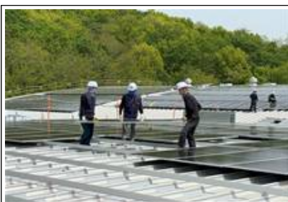
태양광 발전설비 구축공사
