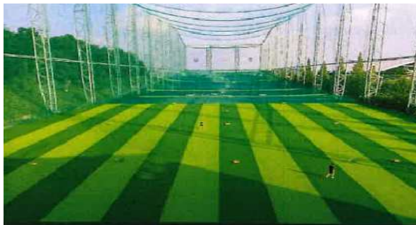
골프연습장 페어웨이 보수공사
